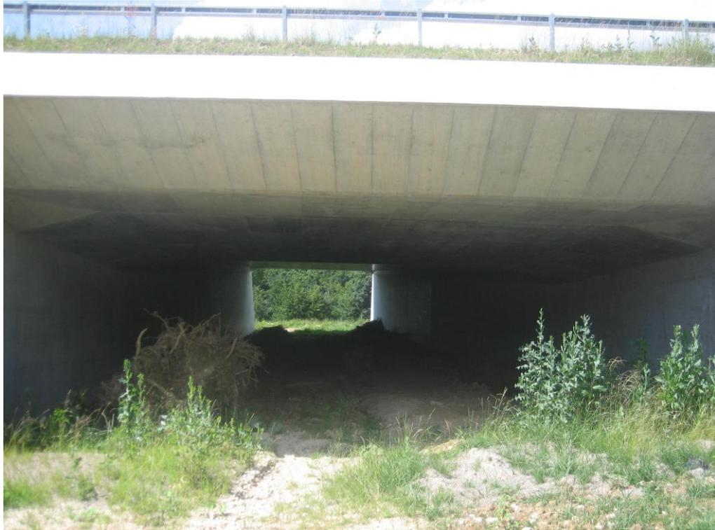
Abb 36 Bei dieser Unterführung an der A16 wurden Strukturen für Kleintiere durch Ausbringen von Wurzelstöcken eingebracht. (Foto: M. Trocmé)
