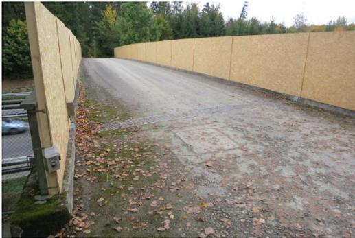
Abb. 19 Provisorischer Blendschutz aus OSB-Holzplatten mit einer Höhe von ca. 2 m. Links vorne sind die installierten Fotofallen zu erkennen, welche querende Wildtiere erfassen.
