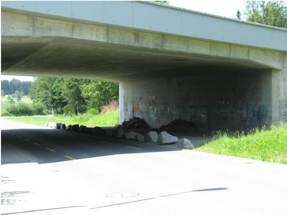
*Abb 35 Unterführung bei Rothenburg für die gemeinsame Nutzung von Strassenverkehr und Wildtieren. Im rechten Bereich besteht ein lockerer Boden mit eingebrachten Strukturen (Steinhaufen), welche Kleintieren Versteckmöglichkeiten bieten. (Foto: A. Righetti)*
