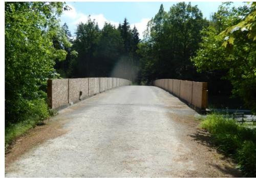
Abb. 20 Am 20.05.2016 wurde die Höhe des Blendschutzes auf die Höhe des Geländers gekürzt (ca. 1,1 m).
