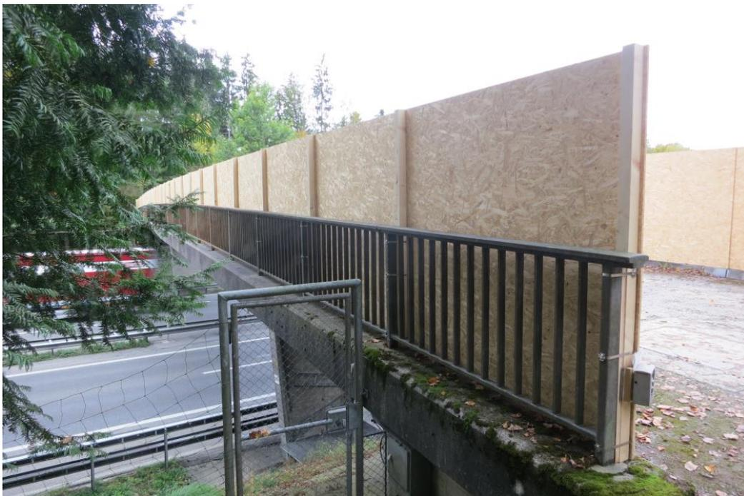
Abb. 21 Die verwendeten OSB-Holzplatten wurden mit der Hilfe von Holzbalken, welche durch Stahlspannbänder am Brückengeländer befestigt wurden, provisorisch installiert.
